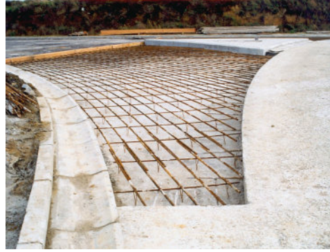
Bağlantı bölgelerindeki plakaların donatıları ve kavşak ana şeridine sabitlenmesi (Kaynak 2)
