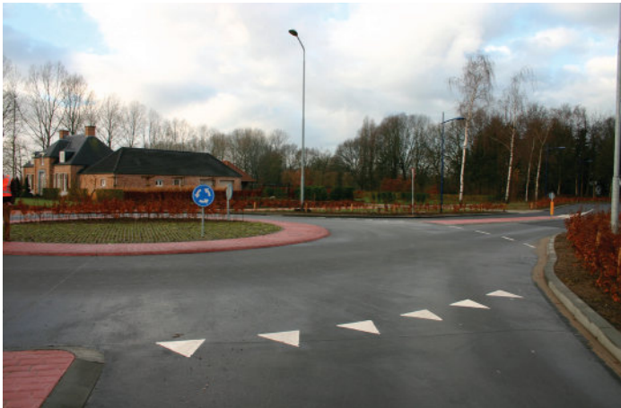
Çelik lifli beton ile imal edilmiş dönel kavşak (Kaynak 1)
