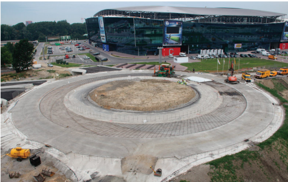
Ayrı süreçlerle farklı şeritlerde beton dökümü (Kaynak : Flaman Karayolları İdaresi AWW)
