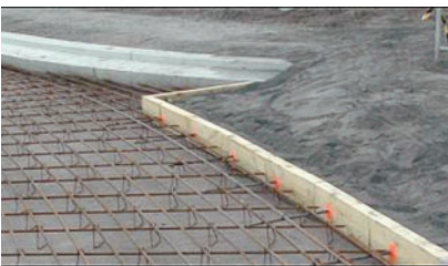
Kavşağa gelen sağlam plakalardan yapılmış sabit kalıp örneği (Kaynak 2)
