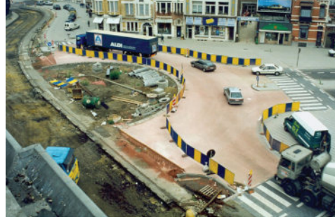
İki aşamalı beton dökümü (Kaynak 2)
