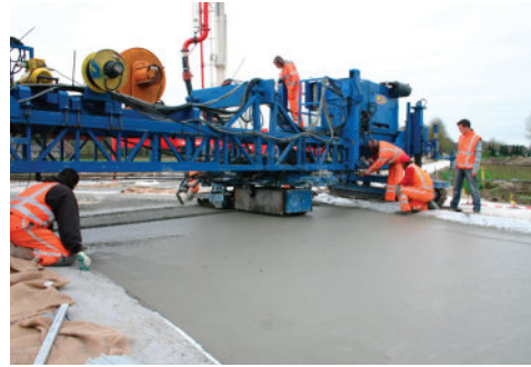
Silindir serici ile beton yerleştirilmesi (Fotoğraf: W. Kramer)
