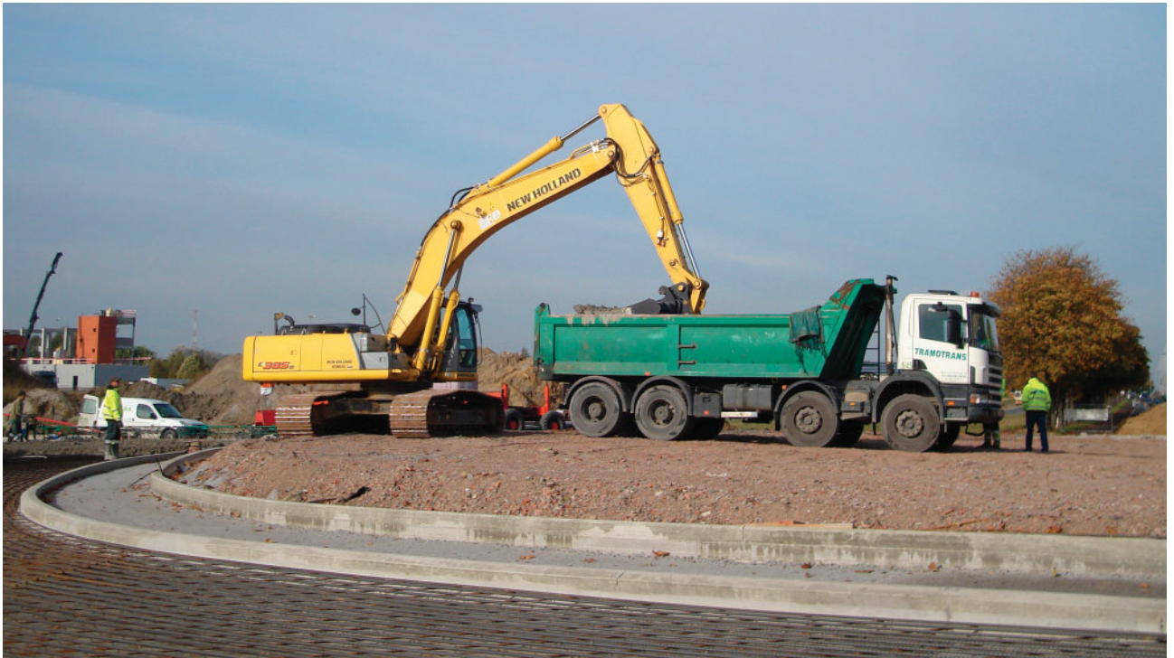
Betonun göbek kullanılarak yerleştirilmesi (Kaynak 2)
