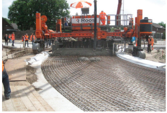
Kayar kalıp ile beton yerleştirilmesi (Kaynak 2 ve 3)
