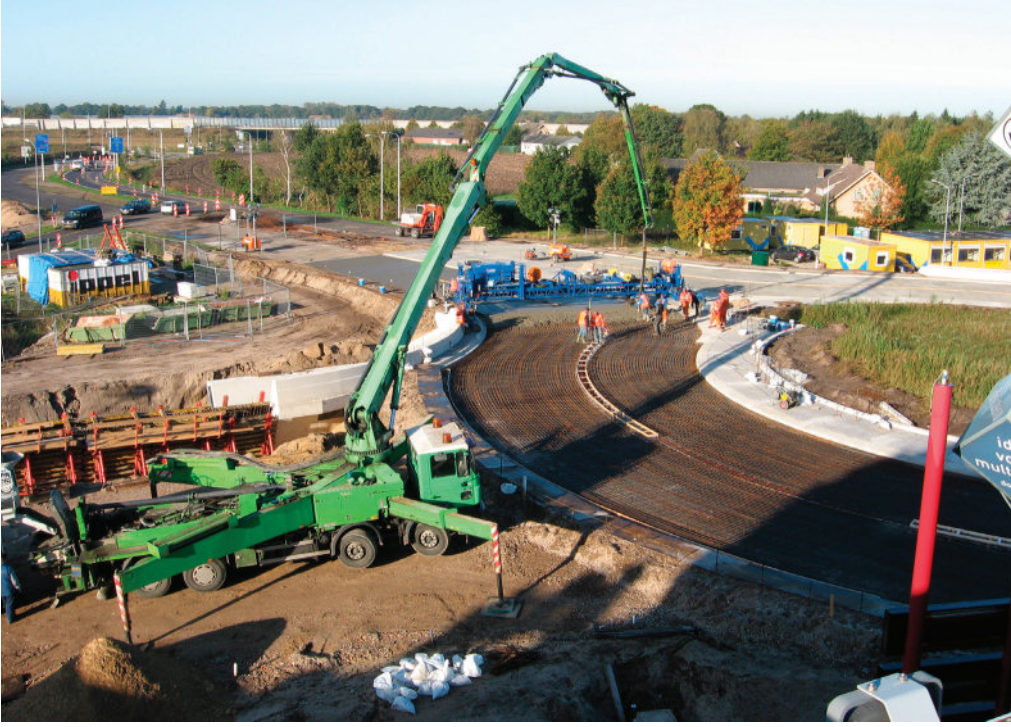
Pompayla beton dökümü
