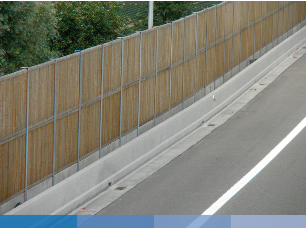
Gürültü bariyerinin önüne yerleştirilmiş basamaklı beton bariyer örneği
