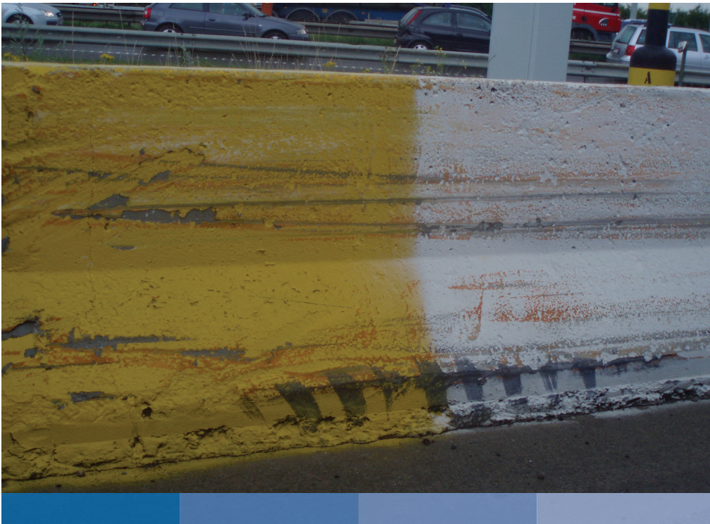
Beton bariyerler üzerinde araç darbelerine karşı direncini gösteren lastik izleri
