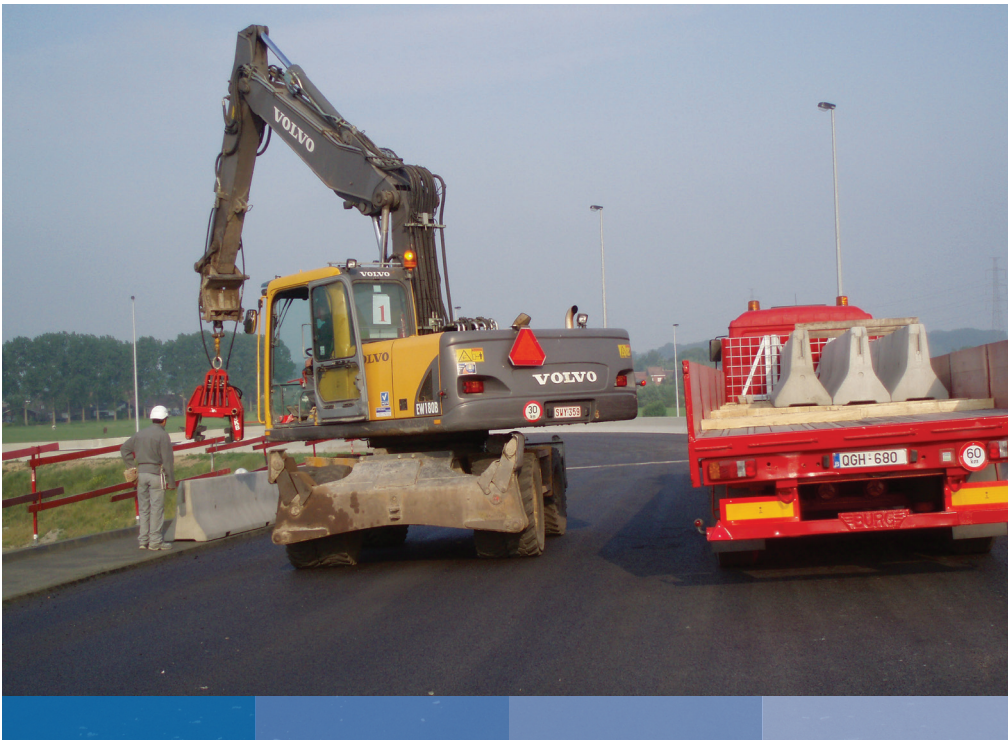
Prefabrik beton bariyerlerin montajı
