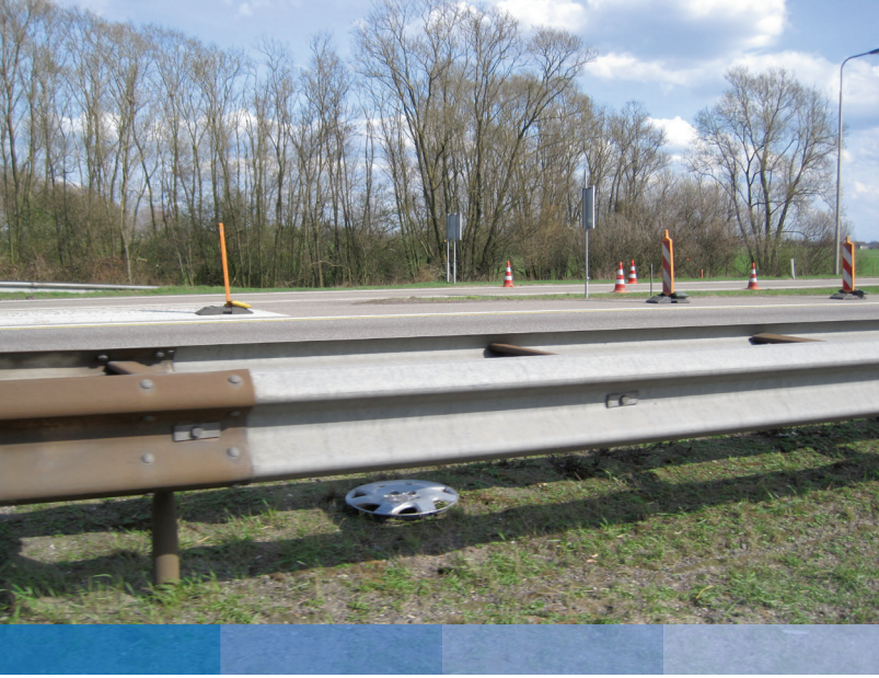
Çelik bariyerin korozyona uğramasına bir örnek
