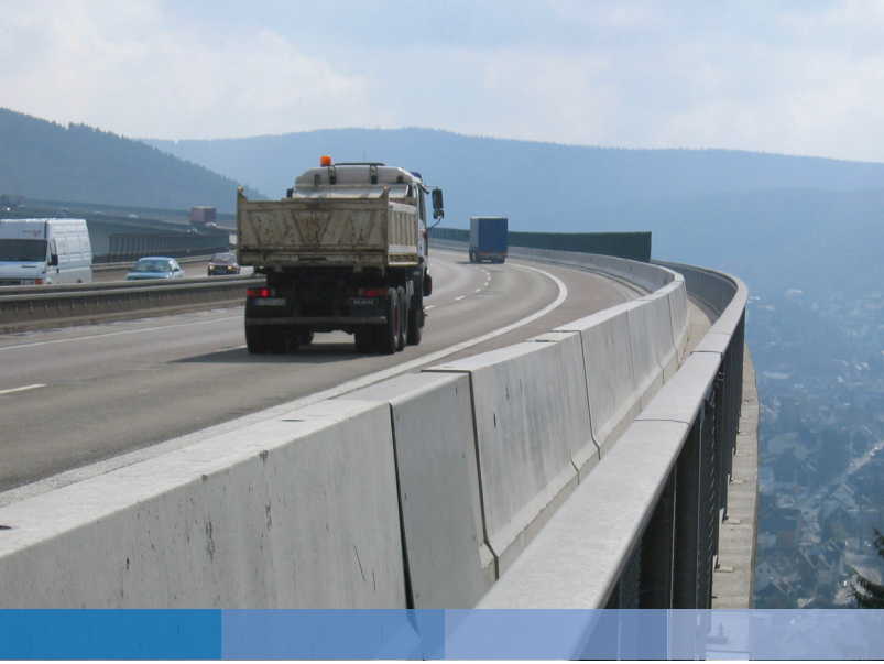
Bir viyadükteki çok yüksek yol tutuş seviyesine (H4b) sahip bir prekast bariyer örneği
