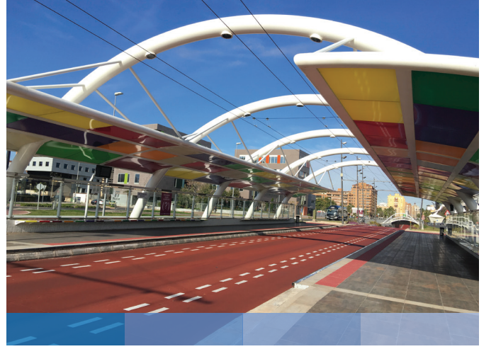
Trolleybüsler için kırmızı reçine kaplı beton şerit, Castellón, İspanya'da Avenida del Mar (Fotoğraf: CEMEX)
