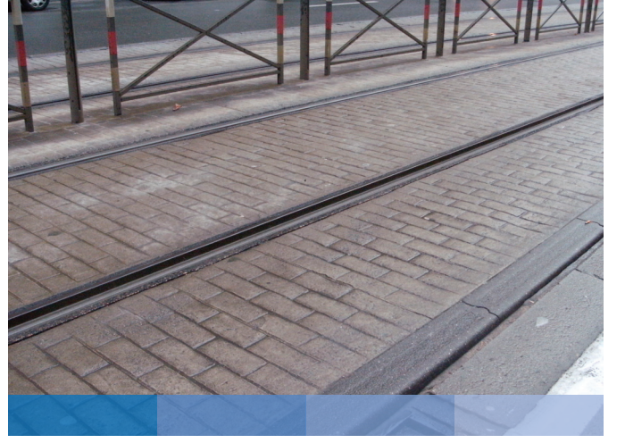
Brüksel, Belçika'da bir tramvay için yapılmış baskı beton yol (Fotoğraf: FEBELCEM)
