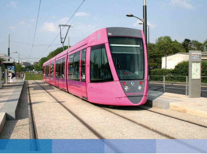
Reims, Fransa'da bir tramvay için görünür agrega yüzeyli beton yol (Fotoğraf: Cimbéton, RevueRoutes 119, 2012)
