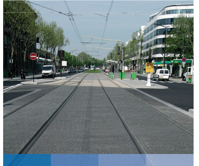
Paris Fransa Maréchaux bulvarında görünür agrega yüzeyli beton tramvay yolu (Fotoğraf: Cimbéton, RevueRoutes 97, 2006)
