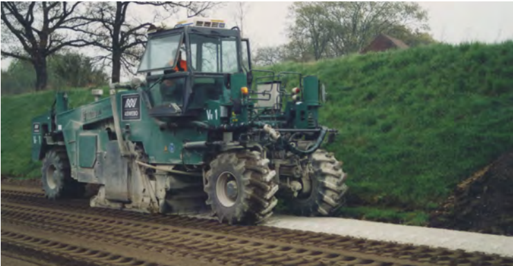
Çimento ile toprak stabilizasyonu
