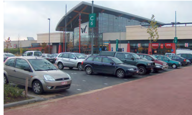
Geçirimli beton bloklarla yapılmış park yeri
