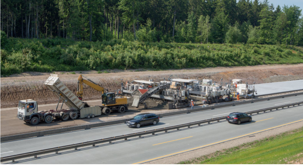
İki katmanlı inşaat
