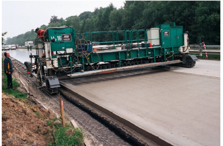
Pürüzlendirme ve kürlenme makinesi
