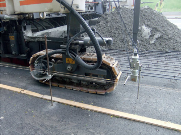
Kayar kalıp finişer için güzergah örnekleri; soldaki
