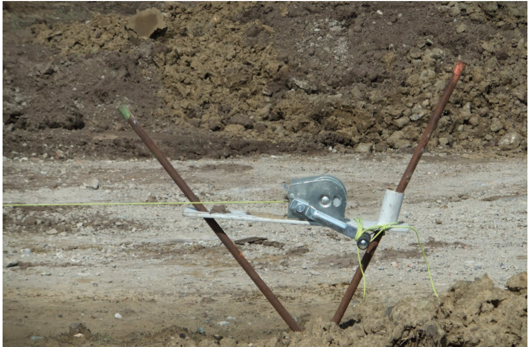
Kılavuz telini germek için kullanılan gerdirme mandalı
