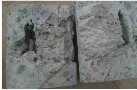
Yerleřtirilen kayma demirinin yetersiz sıkıřtırılması sonucu üzerinde oluşan boşluklar
