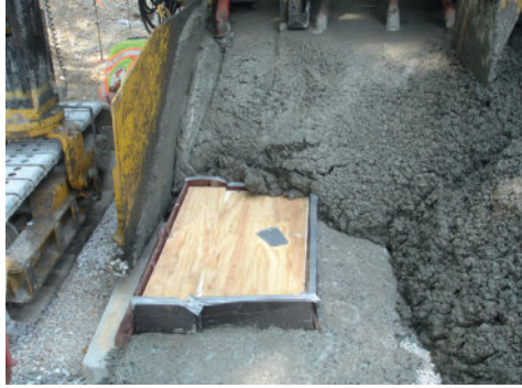
Kaplamada gömülü elemanın yapımı
