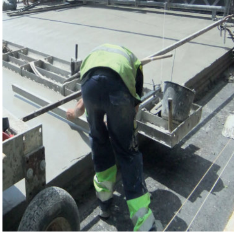
Kenar çökmesinin ölçümü
