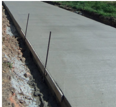
Kenar bozulmasının lokal tamirati
