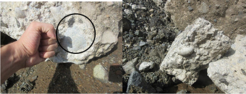
Şekil 8. Of ilçesinde hasarlardan dolayı sökülmiş beton yollarda kaba agregalar.
