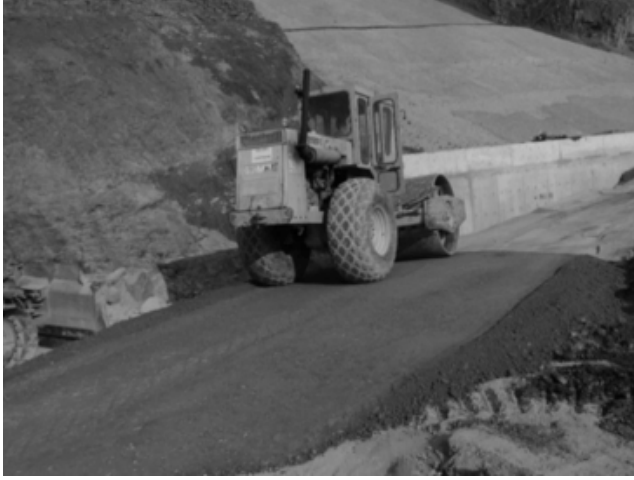
Şekil 2. SSB'nin sıkıştırılması
