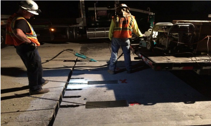
Şekil 13. Ard germe uygulaması
