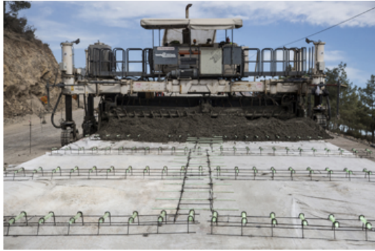
Şekil 9. Beton dökümünden önce kayma demiri sabitlenmesi
