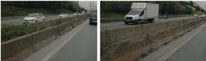
Şekil 5. İstanbul Kartal Samandıra Tem Bağlantı Yolu beton bariyer uygulaması ve çevresel faktörlerin beton bariyerlere etkileri
