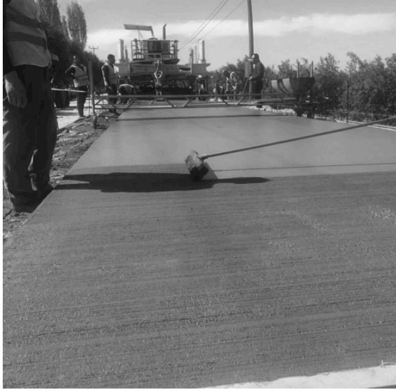
Şekil 7. Beton finişeri ile serilen beton yol uygulaması, yüzey pürüzlendirme
