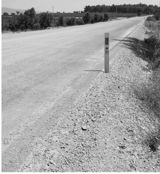
Şekil 5. Silindirle sıkıştırılan beton yol uygulaması, son durum
