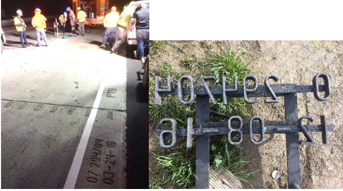
Şekil 8. Panellerin işaretlenmesi
