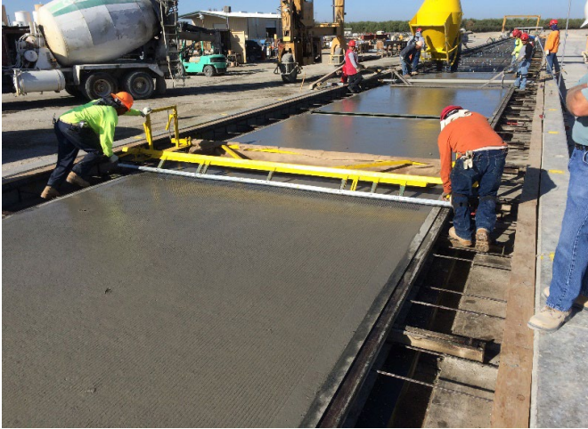
Şekil 6. Döküm sonrası yüzey taraklama işlemi
