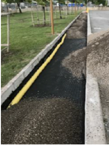
(a) İri agrega ile temel ve rezervuar katmanı yapımı
