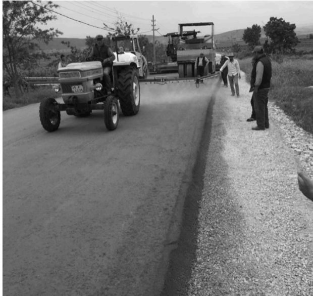
Şekil 4. Silindirle sıkıştırılan beton yol uygulaması, serim ve kütleme
