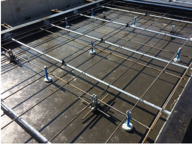
Şekil 4. Öngermeli prekast panel içerisine yerleştirilen ard germe kanalları
