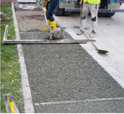
(c) Geirimli betonun serilmesi ve titreřimli master ile sıkıřtırılması
