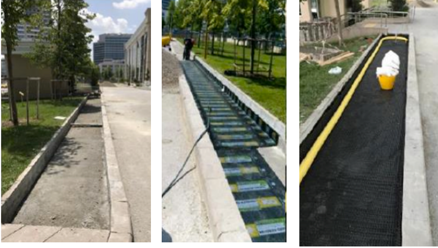
Şekil 7. Geçirimli beton uygulaması öncesinde yapılan işlemler
