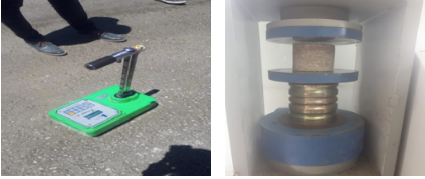
Şekil 10. Cevizli – Bardakçı Yolu yapılan çalışmalar ve deneyler
