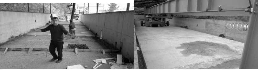
Şekil 8. Tesiste deneyler için beton yol yapımı.
