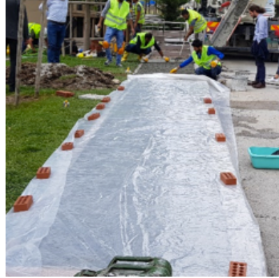
(e) Plastik bir rt ile betonun bakımının yapılması
