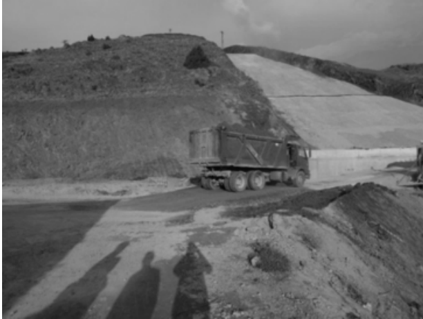
Şekil 3. SSB yüklü kamyonların yapılan yoldan geçişi
