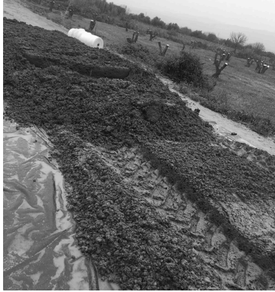
Şekil 3. Silindirle sıkıştırılan beton yol uygulaması, beton kıvamı
