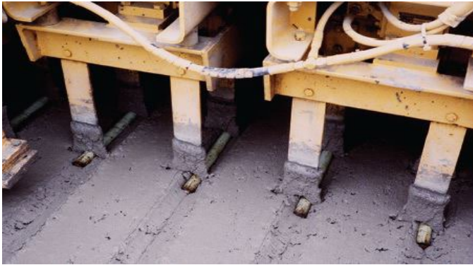
Şekil 10. Otomatik kayma demiri yerleştirilmesi
