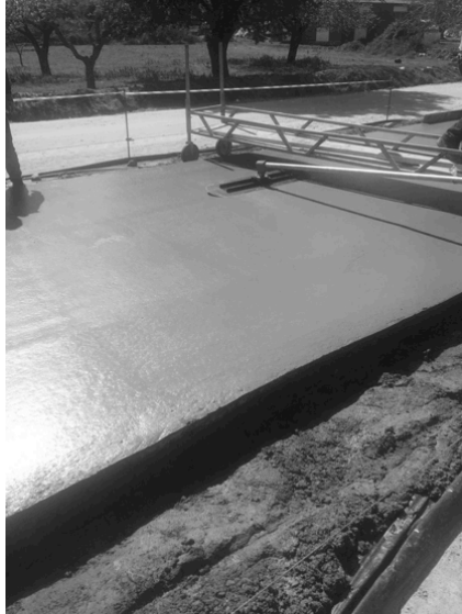
Şekil 6. Beton finişeri ile serilen beton yol uygulaması, serim
