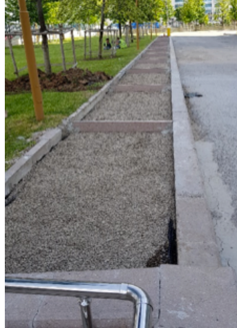
(b) Derz plakalarının yerleştirilmesi ve sabitlenmesi
