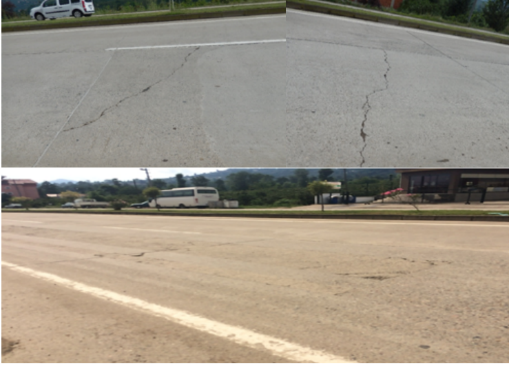
Resim 3. Taşıma Gücü Yetersizliğine Bağlı Bozulmalar, Enine ve Köşe Çatlamları
