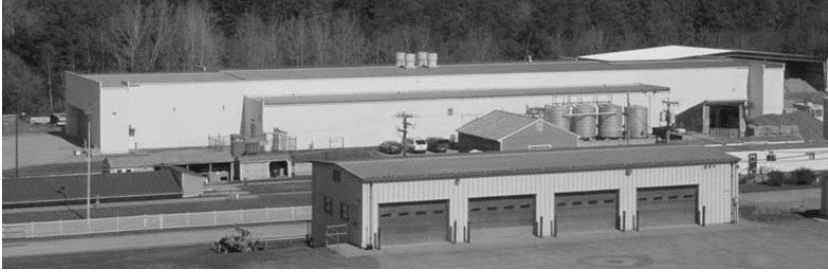
Şekil 2. CRREL-HVS Sođuk hava deposuna yapısı (URL 2, 2019).
