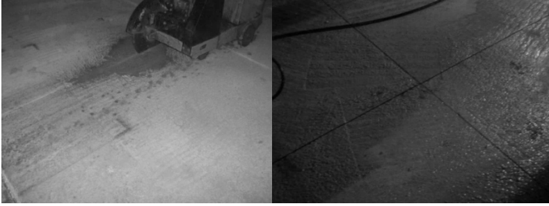
Şekil 10. Beton plaklarda derz kesimi.
