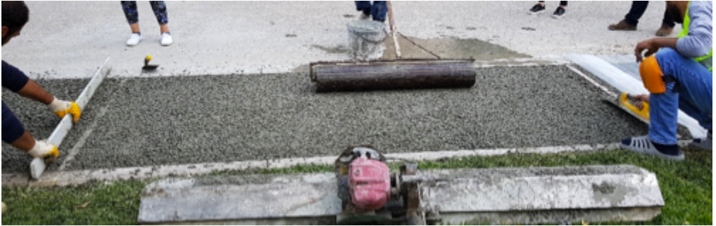
(d) Betonun silindir master ile yüzeyinin düzeltilmesi
