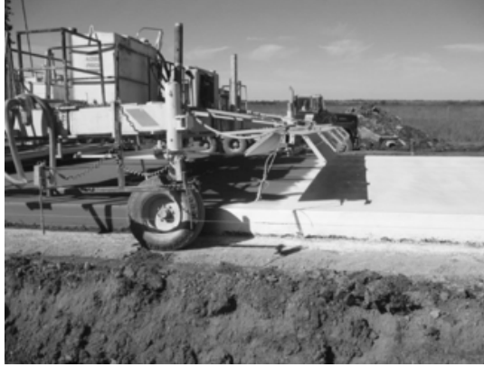
Şekil 3. Beton yolda kimyasal kür uygulaması
