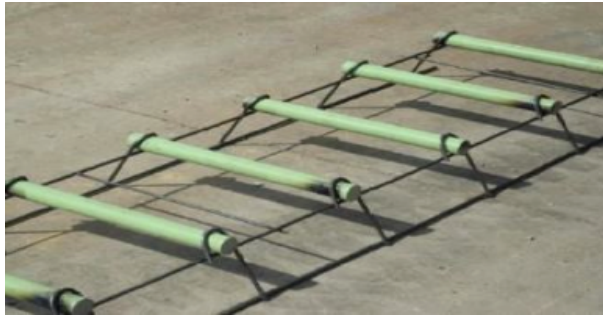
Şekil 7. Örnek kayma demiri yerleşimi
