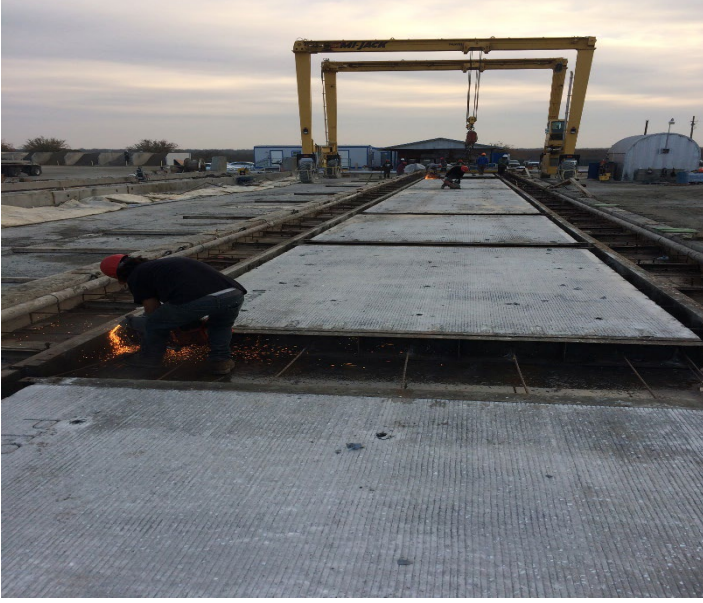
Şekil 9. Ön germe kuvvetinin prekast panellere transferi
