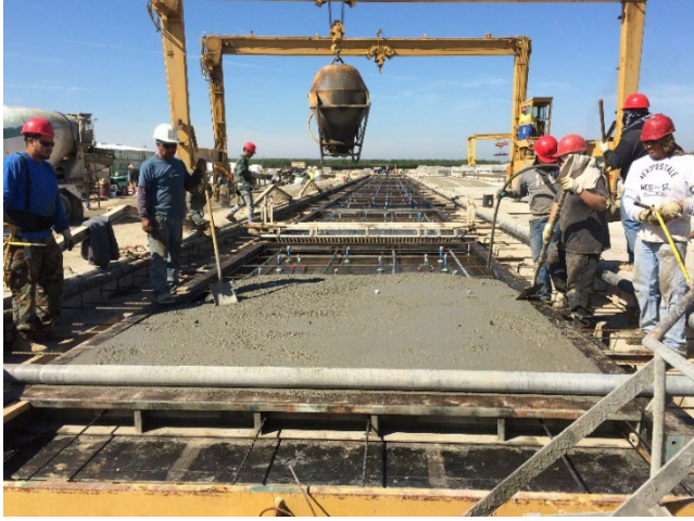
Şekil 5. Öngermeli prekast panel hattı
