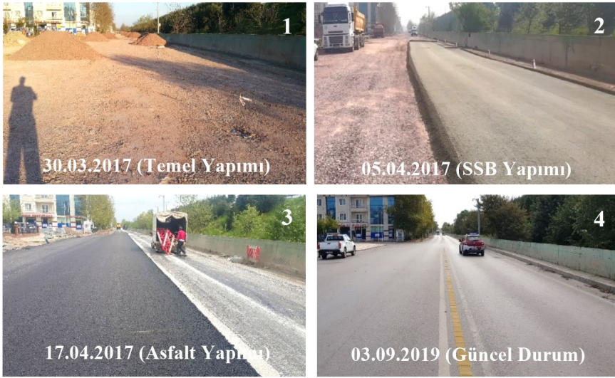
Şekil 5. Yol katmanlarının yapımı ve yolun güncel durumu
