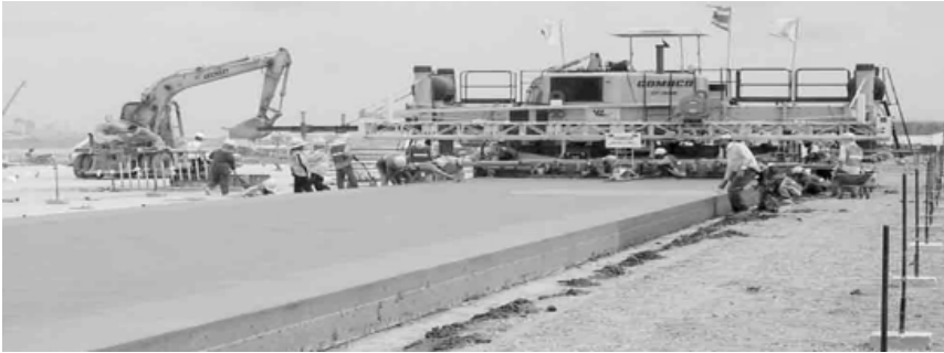
Şekil 1. Beton yol imalatı
