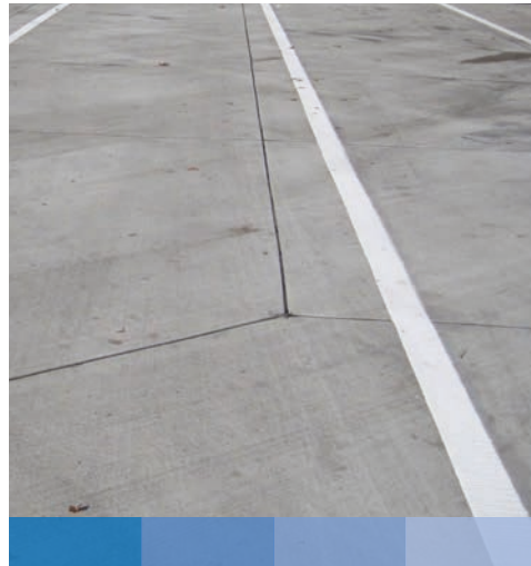
Avusturya ve Almanya'da karayolu park alanlarında derz yerleşimleri (sağdaki fotoğraf: Betonhuis, NL).
