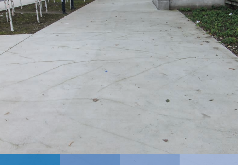
Taze betonun yeterince korunmamasından kaynaklanan rastgele rötne çatlakları
