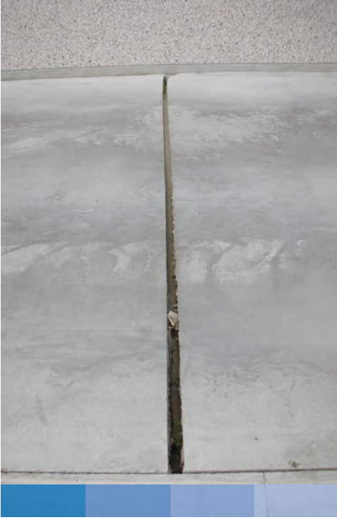
Plastik örtü üzerinde kaydığı için fazla geniş açıklıklı derz
