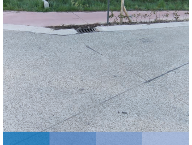
Avusturya ve Almanya'da karayolu park alanlarında derz yerleşimleri (sağdaki fotoğraf: Betonhuis, NL).
