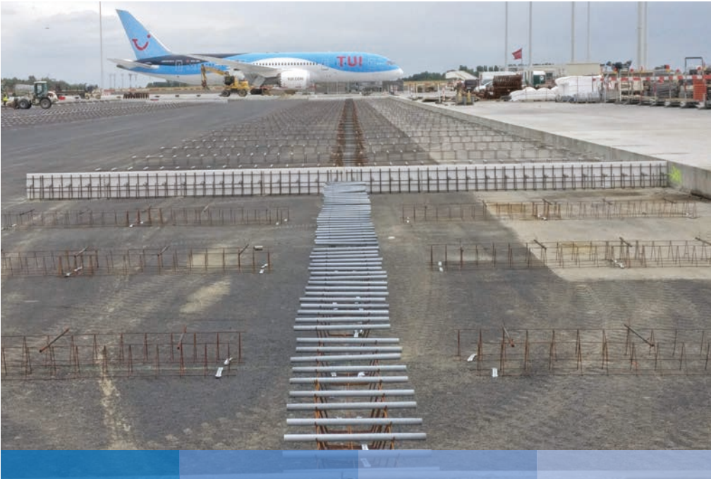
Brüksel Havaalanında asfalt tabaka üzerine JPCP yapımı
