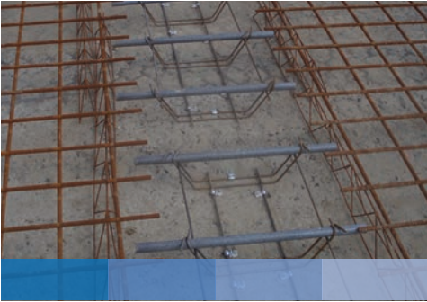
Birleştirilen çelik hasırlar ve kayma demirleri
