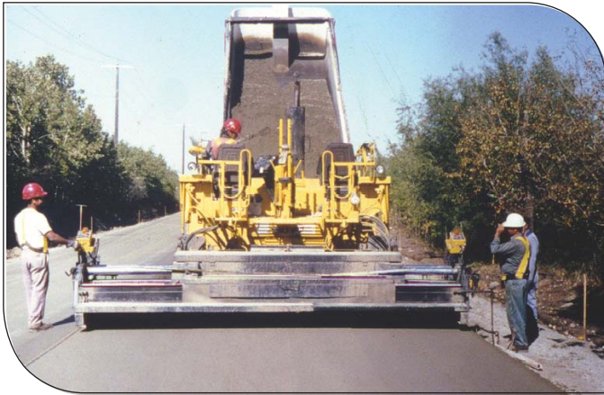
Yol genişletme çalışmaları silindirle sıkıştırılmış betonla kolaylaşmıştır.
