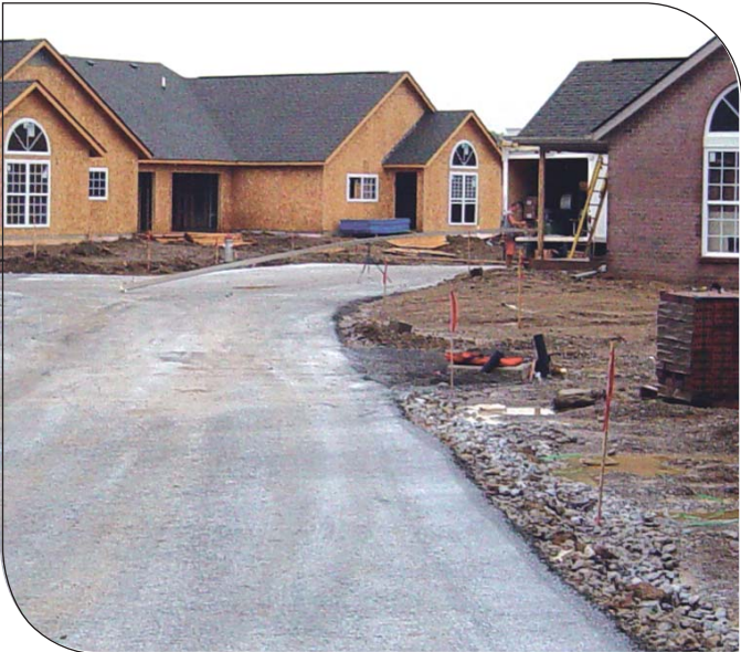
Columbus şehir sokakları hızlı ve kullanışlı olarak SSB tipinde inşa edilmiştir. Kent sakinleri, yapımdan kısa bir süre sonra SSB kaplamayı kullanabilmektedir.
