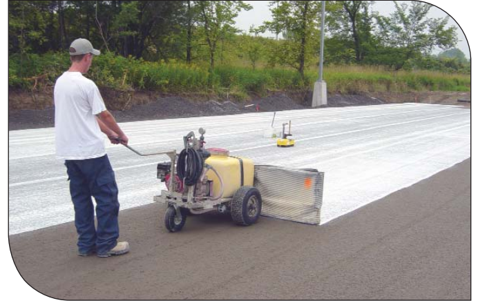
Uzun vadeli performansın anahtarı yeterli küreme işlemidir. Tipik olarak su veya kimyasal kür malzemeleri kullanılır.
