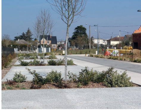
Geçirimli beton yol üstyapısından park yeri, Dreux (Fransa) © CIMbéton
