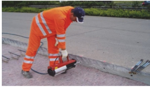
Şekil 4.11. Ankraj uygulaması (PIARC, 2013)
