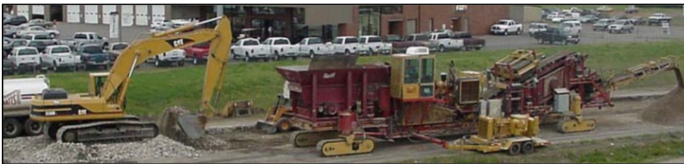
Şekil 4.13 Yerinde geri dönüşüm (Snyder ve diğerleri, 2018)
