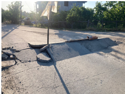
Şekil 3.15. Yüksek şiddetli basınç patlaması
