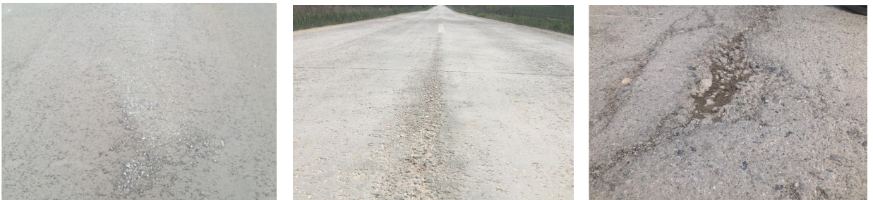
Şekil 3.4. Düşük-orta-yüksek şiddetli segregasyon örnekleri
