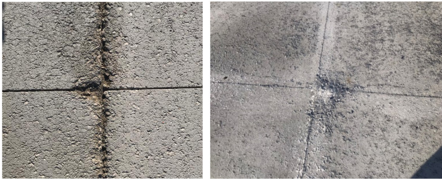
Şekil 2.12. Derz köşe parçalanması
