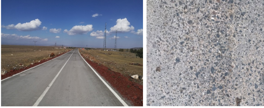
Şekil 2.1. Agreganın cilalanması
