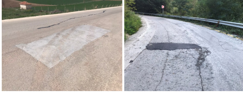
Şekil 2.19. Yama ve yama bozulmaları
