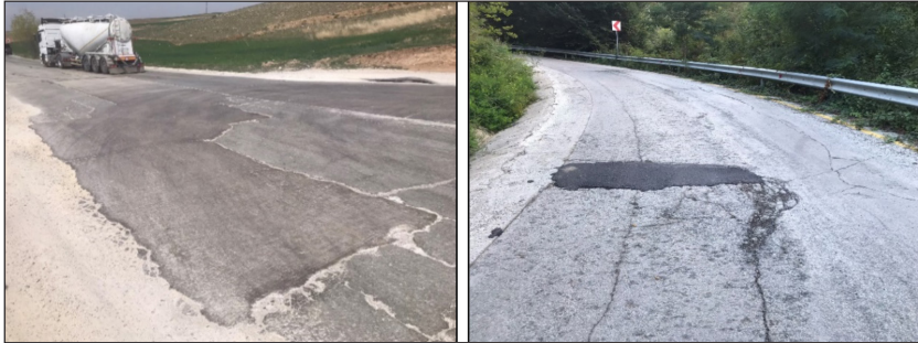
Şekil 3.18. Yüksek şiddetli yama ve yama bozulmaları
