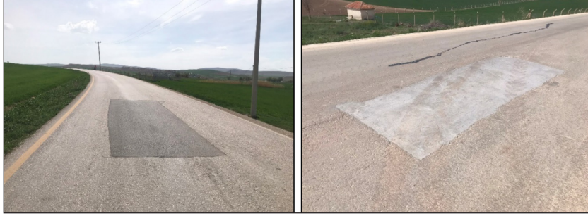
Şekil 3.16. Düşük şiddetli yama ve yama bozulmaları
