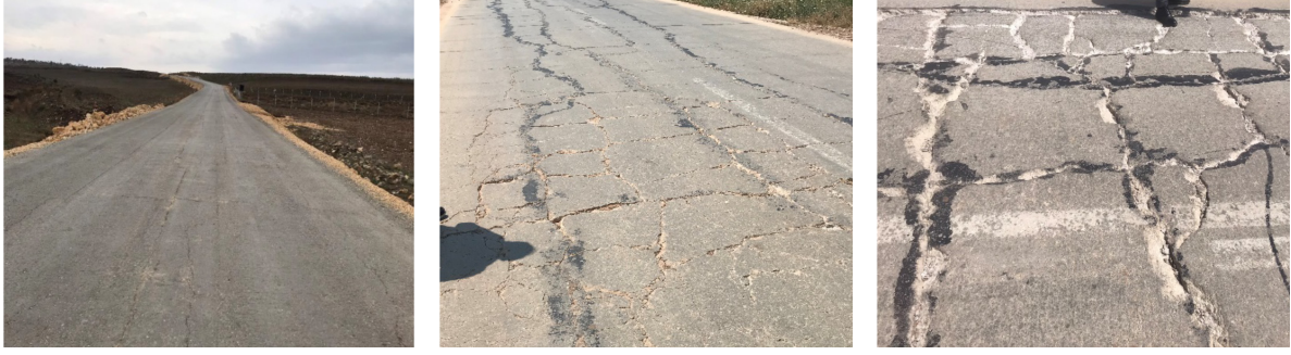
Şekil 3.8. Düşük-orta-yüksek şiddetli plak bölünmesi örnekleri
