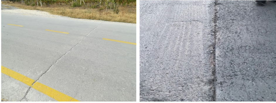
Şekil 2.13. Derz boyunca parçalanma
