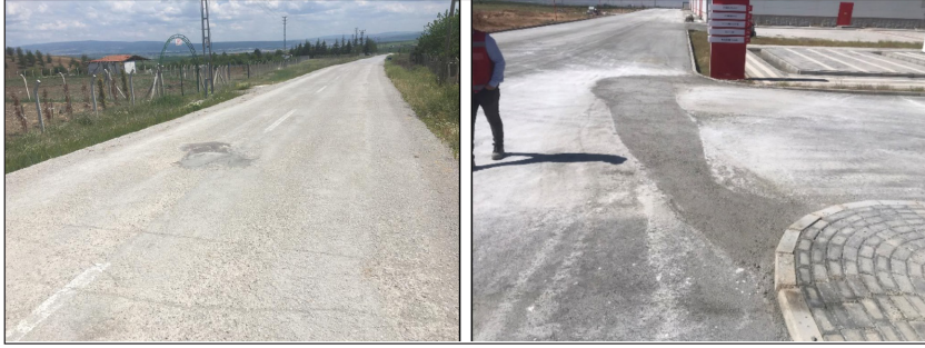
Şekil 3.17. Orta şiddetli yama ve yama bozulmaları
