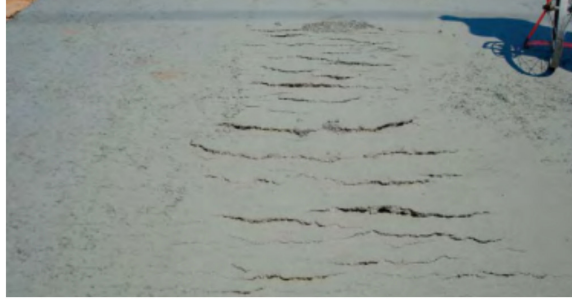
Şekil 2.5. Sıkıştırma Kaynaklı Yırtılma (Harrington ve diğerleri, 2010)
