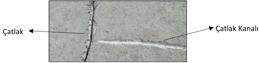
Şekil 4.3. Çatlak kanallarının oluşturulması
