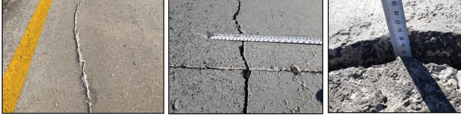
Şekil 4.2. Çatlak şiddetinin belirlenmesi
