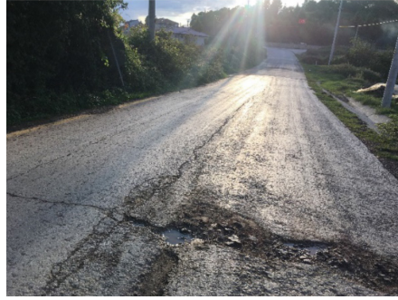
Şekil 3.19. Pompaj etkisi
