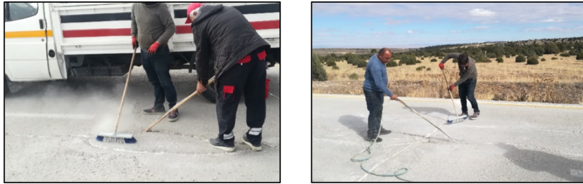
Şekil 4.4. Çatlakların temizlenmesi
