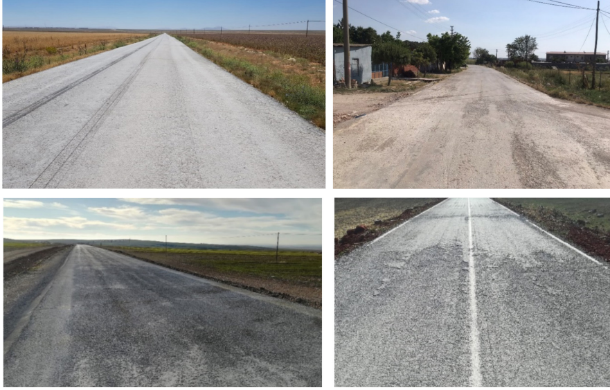
Şekil 2.3. Soyulma ve agregas sökülmesi
