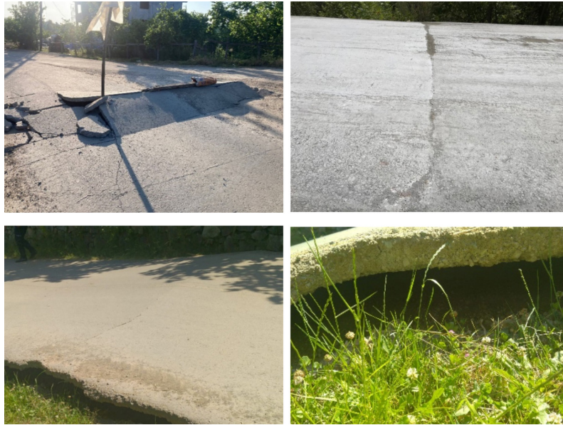
Şekil 2.18. Basınç patlaması
