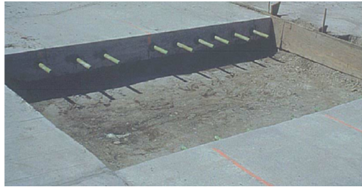
Şekil 4.12. Ankraj uygulaması (PIARC, 2013)
