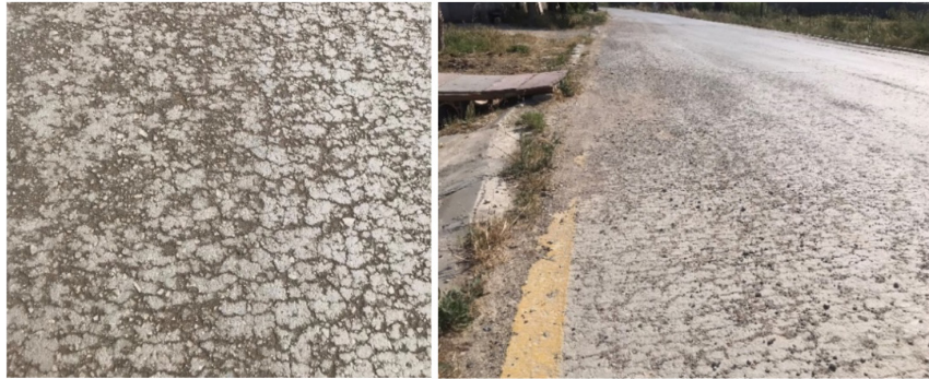
Şekil 2.10. Harita şeklinde çatlama
