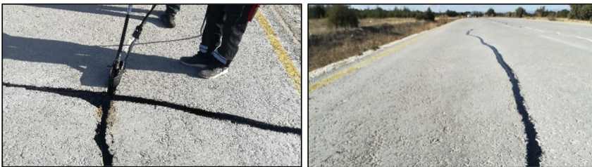
Şekil 4.5. Dolgu malzemesi uygulanması
