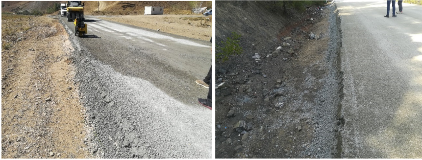
Şekil 2.16. Plak kenar sökülmesi
