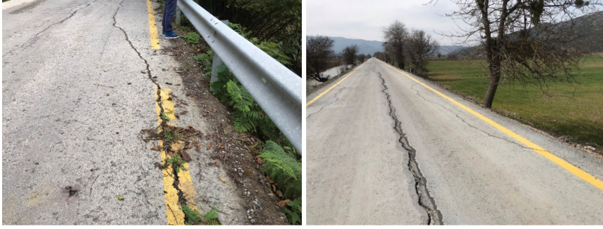
Şekil 2.15. Şerit ve kenar kayması
