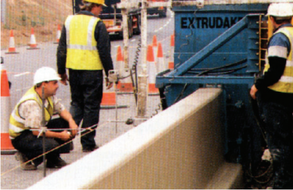
Kayar kalıp finişer ile dökümü
