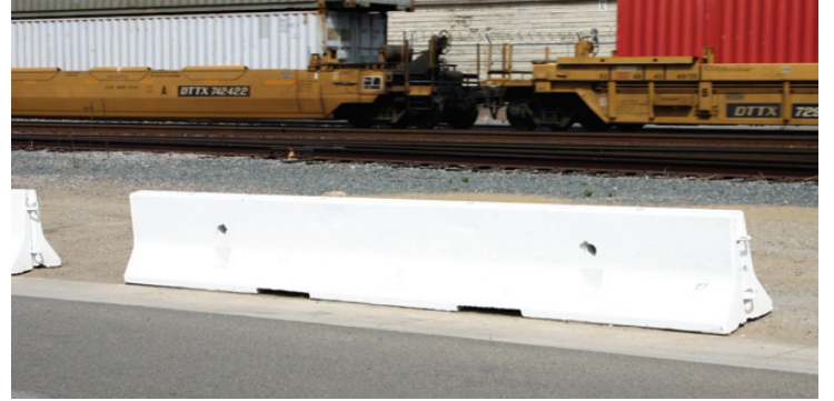
Şekil 10: Portatif, Hareketli beton bariyerler
