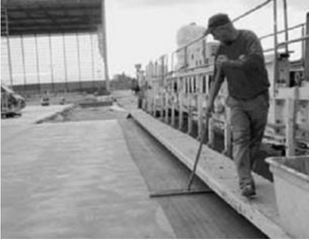
Resim 6.2 Fırça ile Enine Yüzey Dokulandırma
