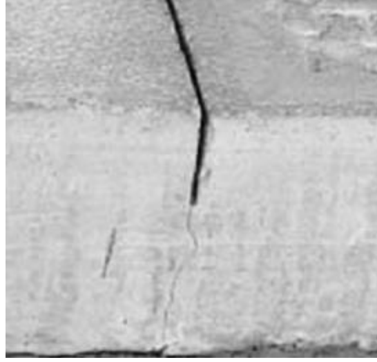
Resim 6.8 Planlanan Çatlak ile Birlikte Enine Büzülme Derzleri
