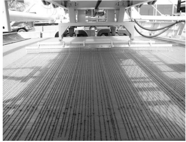
Resim 6.3 Araç ile Yapılan Enine Yüzey Dokulandırma
