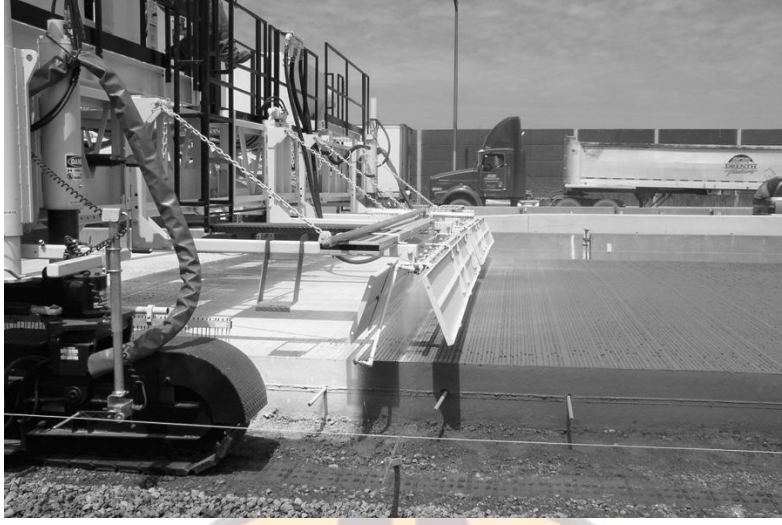
Resim 6.10 Kimyasal Kür Uygulamasının Araç ile Yapılması
